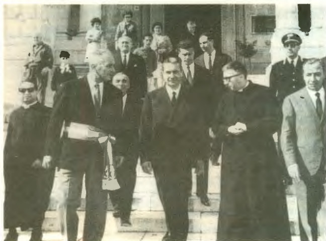
Una delle visite dell'on. Aldo Moro. Don Peppino davanti la chiesa gli ha mostrato lo stato di avanzamento dei lavori
