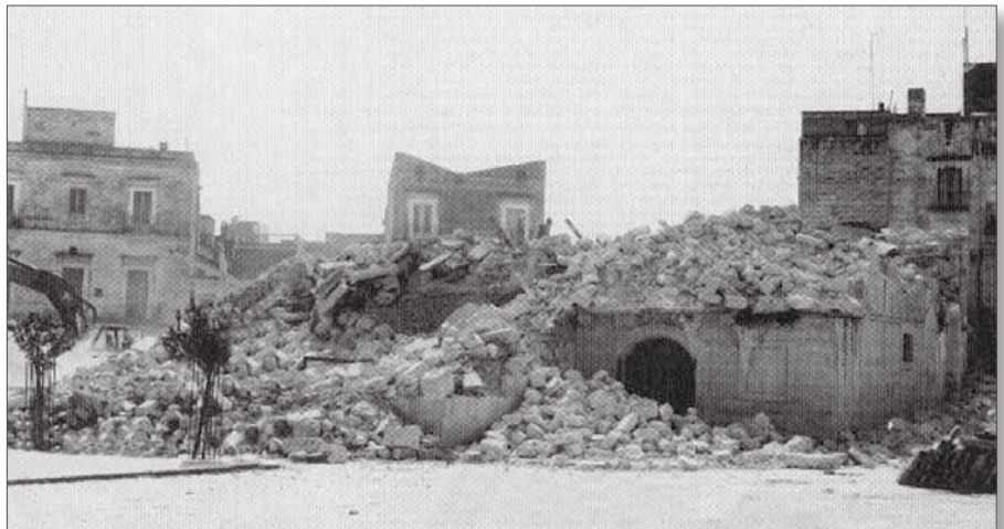
Demolizione della chiesa della Madonna del Soccorso
